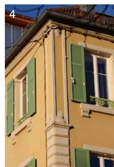
1 : Lambrequin - 2 : Bandeau - 3 : Balcon, porte, encadrement de fenêtre - 4 : Chainage d'angle
