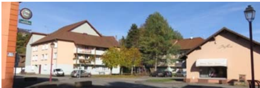
Les appartements à Étueffont, rues de l'usine et de Giromagny - Photo : AUTB
