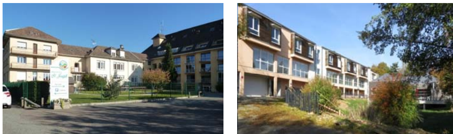
Les Résidences Saint-Joseph et Les Vergers à Giromagny et Rougemont-le-Château Photos : AUTB
