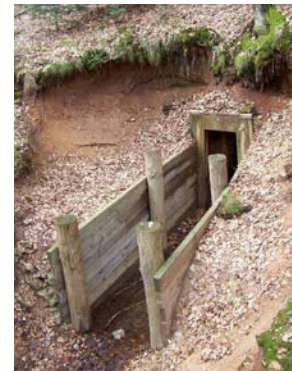
Entrée de la mine en grès à Giromagny
