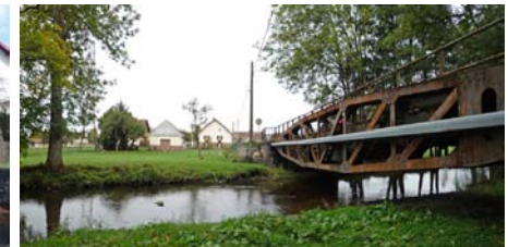
Le pont d'Arromanches à Chauv - (AUTB)
