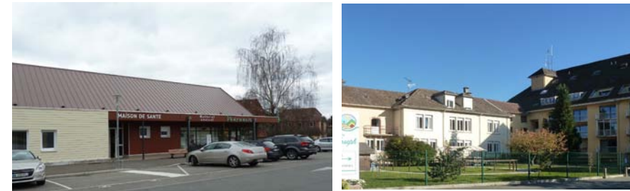
Maison de santé à Rougemont-le-Château / Résidence Saint-Joseph à Giromagny (AUTB)
