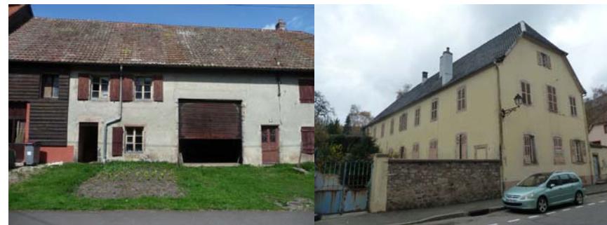
Un logement inoccupé à Lepuix et l'ancien presbytère à Giromagny
